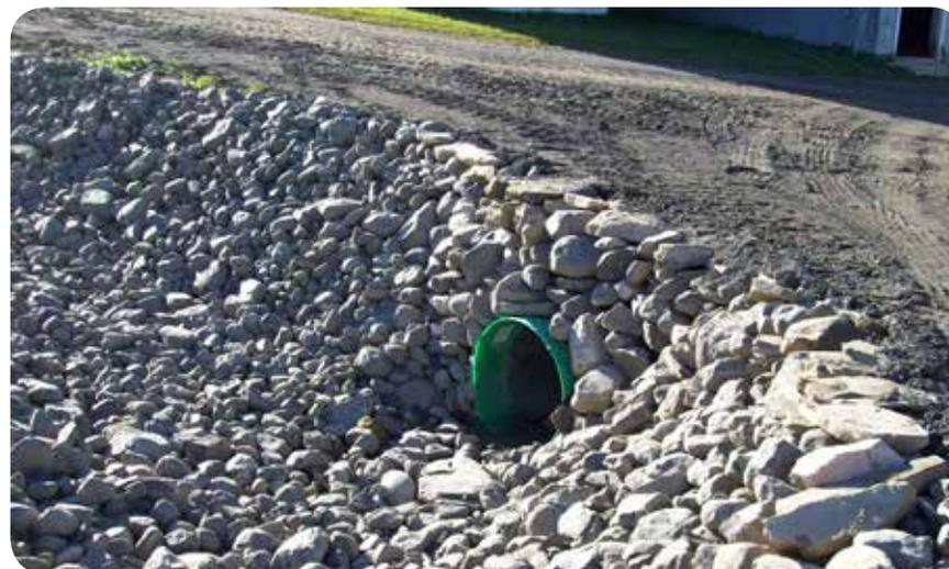
Figure 35 : Ponceau stabilisé au niveau des abords, des berges et du fond du fossé, Source : OBVMR
