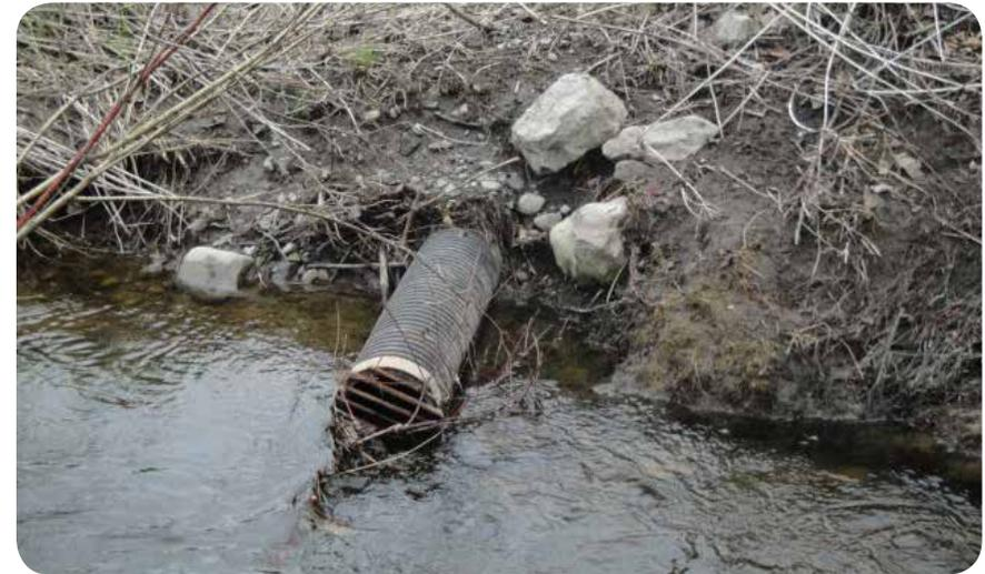
Figure 25 : Érosion en sortie de drain, Source : OBVMR
