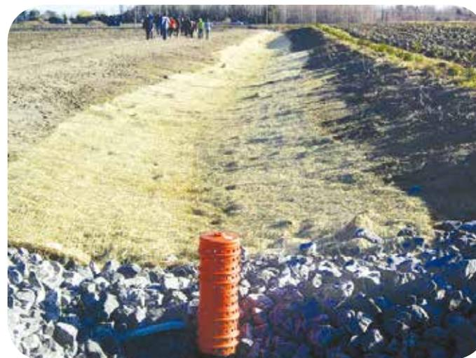
*Figure 16: Voie d'eau engazonnée avec déversoir enroché, Sources : Fiche technique voie d'eau et rigole d'interception engazonnée, MAPAQ et AAC*
