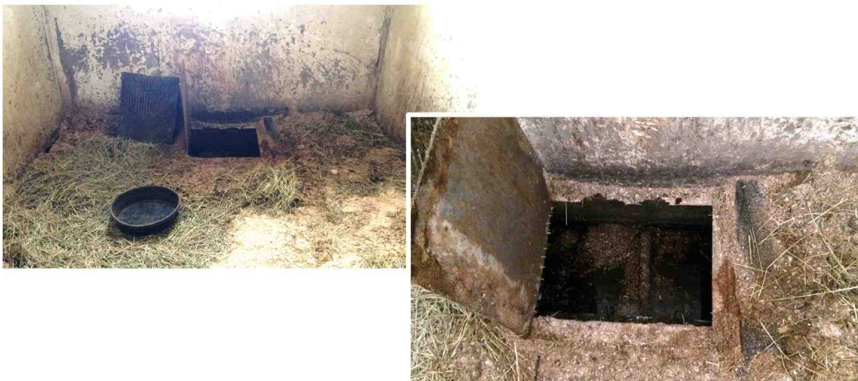
Photos 6 et 7 : Trappe donnant accès au dalot de l'écurieur
