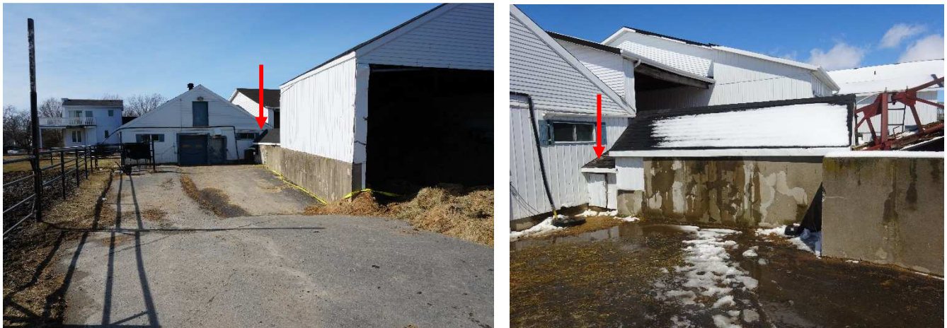
Photos 1 et 2 : Abri de la montée d'écurieur – section dans laquelle est retrouvé le travailleur
