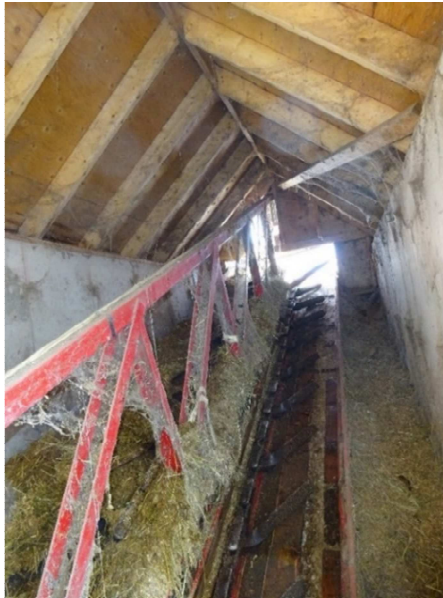
Photo 15 : Montée d'écurieur dans la deuxième section de l'abri
