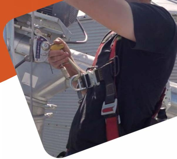
Les échelles fixes pour accéder au-dessus d'un bâtiment (comme un silo) doivent être munies d'un dispositif antichute lorsqu'il y a un risque de chute d'une hauteur de plus de six mètres. On trouve généralement deux types de dispositif antichute :
