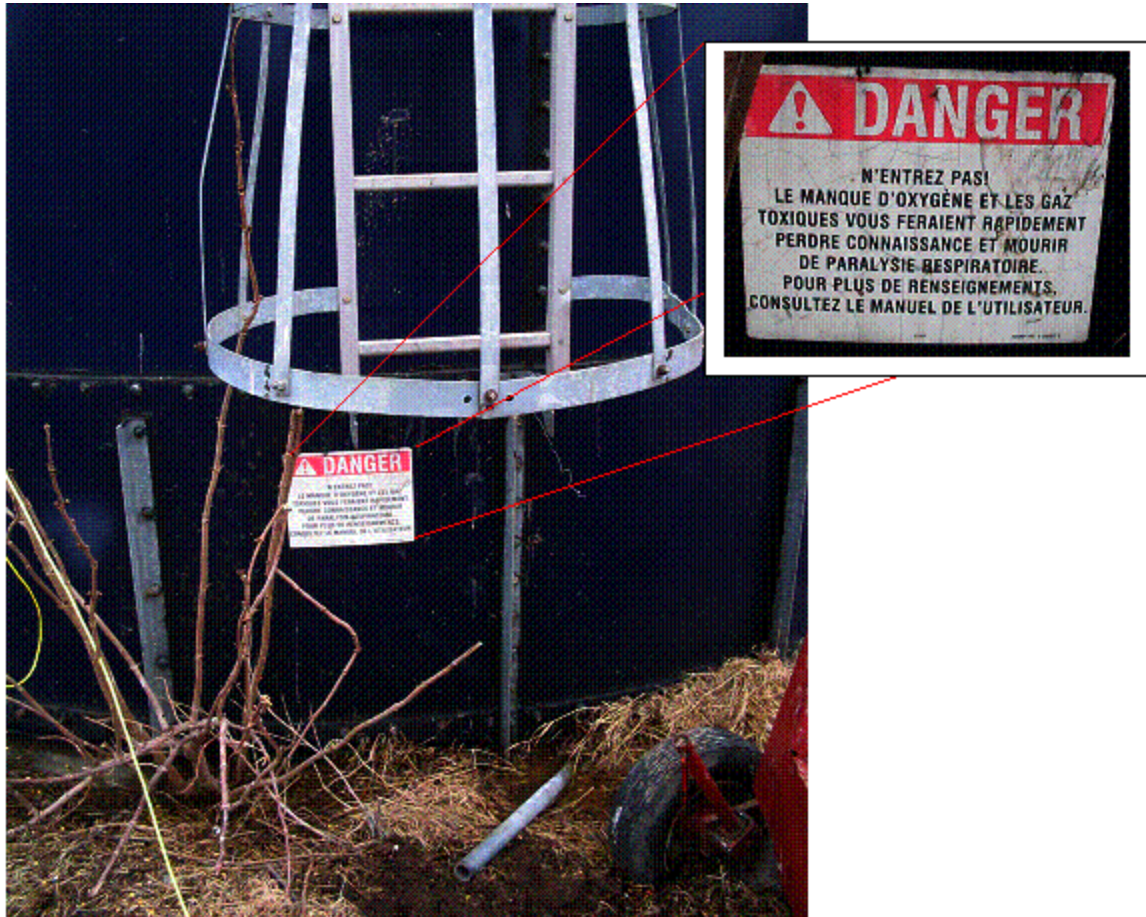
Figure 2 – Échelle d'accès pour le toit du silo et indication de danger
