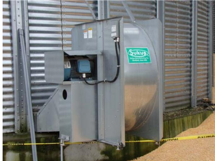
Photo 4 – Ventilateur permettant la ventilation des grains
