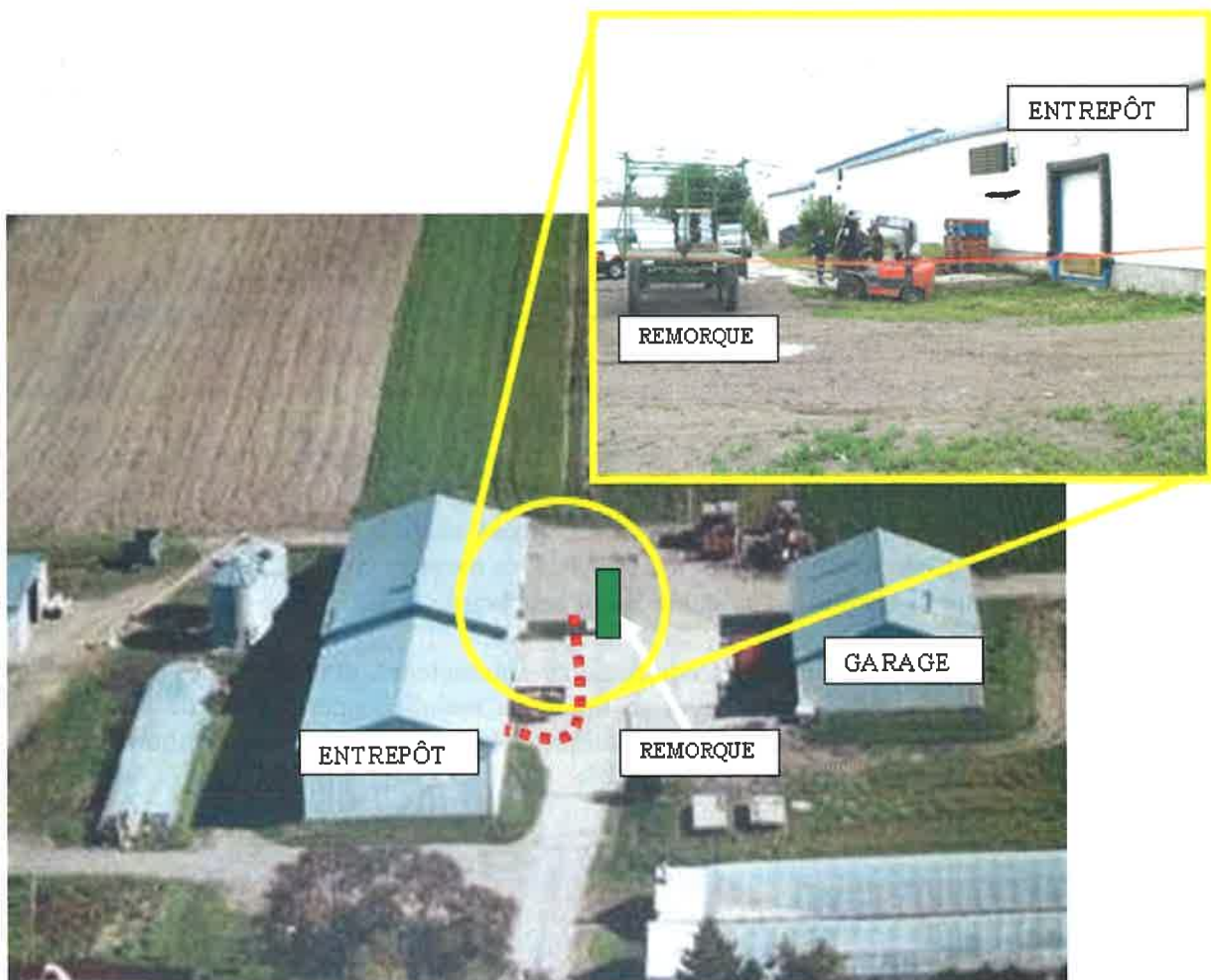
Photo 2 : Lieu de travail – Source : Potager Grandmont, modifié par CSST.
