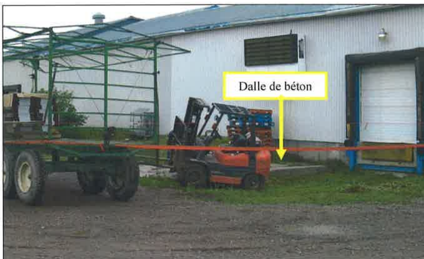
Photo 3 : Dalle de béton – Source : CSST.
