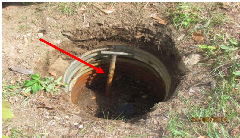
Photo 7: Tige servant à actionner la valve située au fond du trou (Source: CSST)
