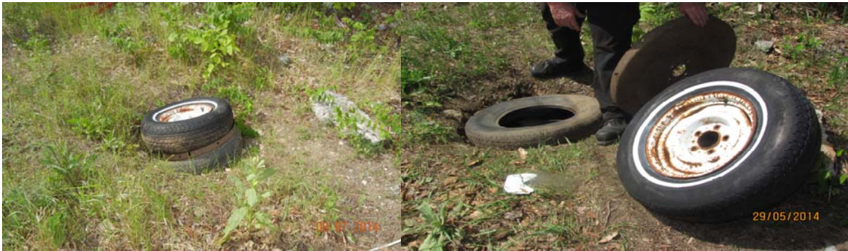
Photo 6: Plaque métallique et pneu servant de couvercle au trou d'homme (Source: CSST)
