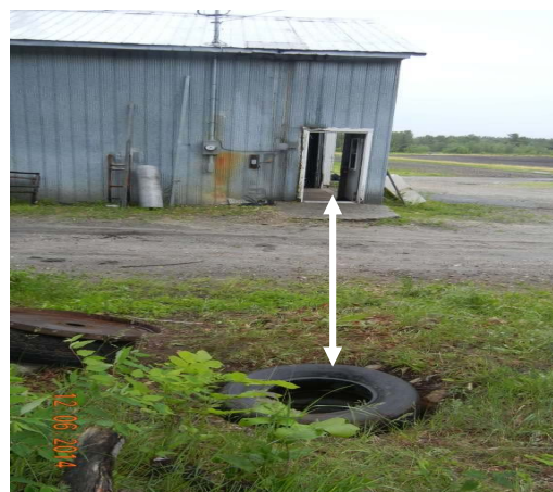
Photo 3 : Distance entre le garage et le trou d'homme (Source: CSST)
