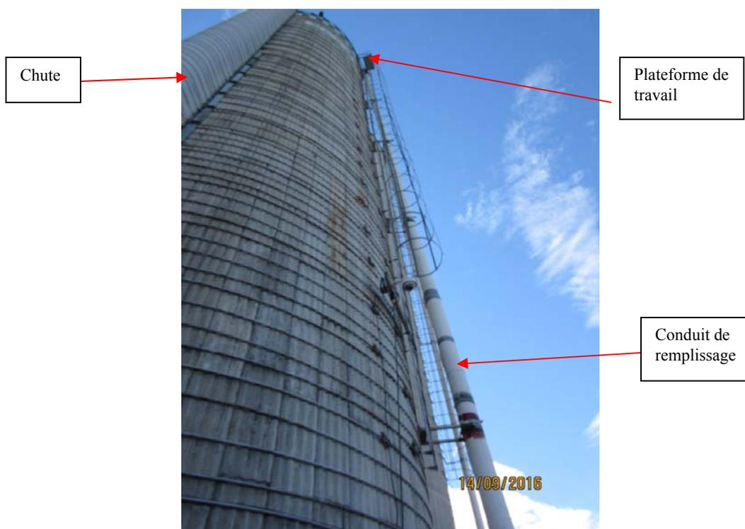
Photo 3a) : vue en contre-plongée de l'échelle extérieure et de la plateforme
