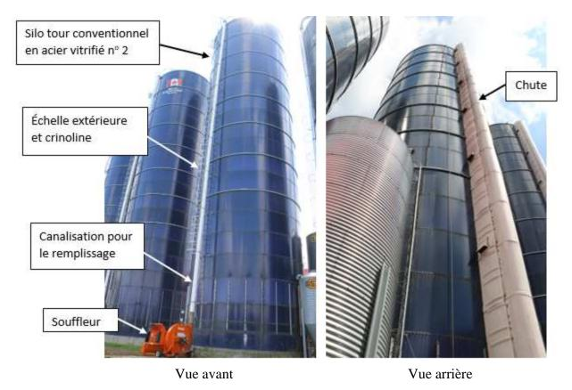
Figure 3 : Silo tour conventionnel en acier vitrifié (Source : CNESST)
