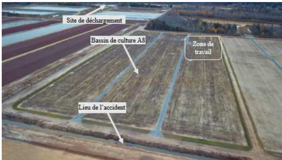
Figure 3 : Site des travaux de désherbage (Source : CNEST)
