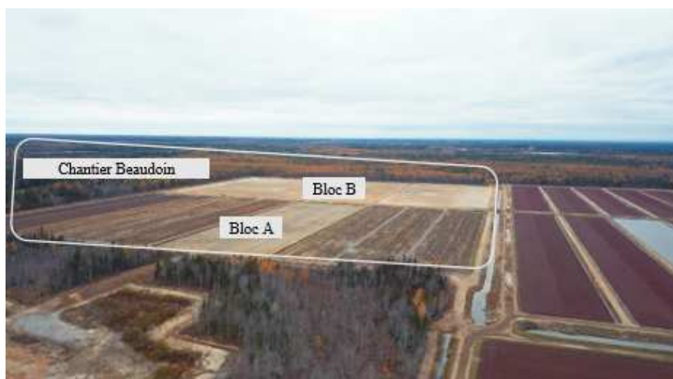
Figure 2 : Chantier Beaudoin (Source : CNESST)
