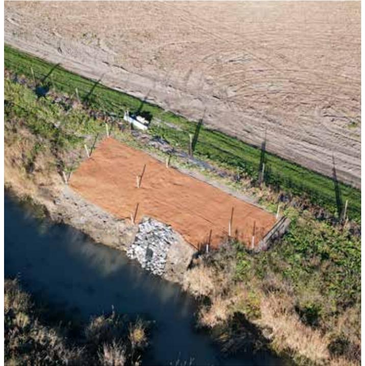
À Mont-Saint-Grégoire, avec la collaboration du Groupe ProConseil, neuf remplacements de sorties de drains avec chutes enrochées furent réalisés.
